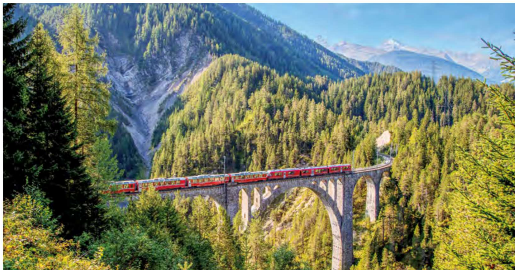
Bernina Express auf dem Wiesnerviadukt
